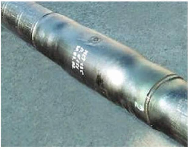
**4.5.17.** Заварить отверстия П/Э пробками. Для этого нагреть инструмент для заварки пробок до температуры не более 240 С0 (полиэтилен не должен дымиться) Вставить П/Э пробку во внутренний конус инструмента, наружный конус вставить в заливочное отверстие и, нажимая на П/Э пробку вдавливать инструмент в отверстие муфты. Когда пробка углубится на 2мм в конус, вынуть инструмент и вдавить в отверстие муфты оплавленную пробку. Удерживать пробку под давлением в течение 20сек.
