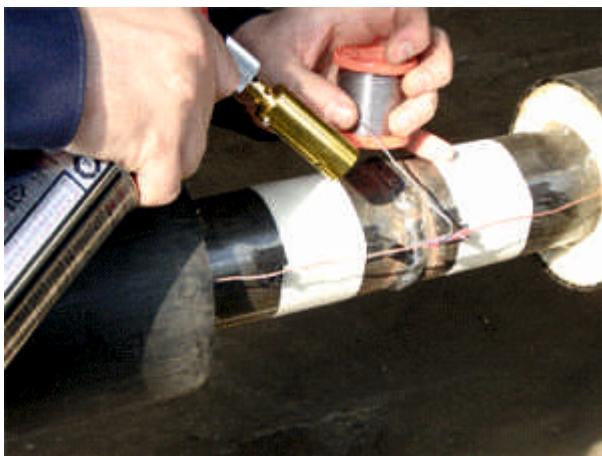
Обработанное соединение запаять с использованием припоя и паяльника газового либо электрического.
