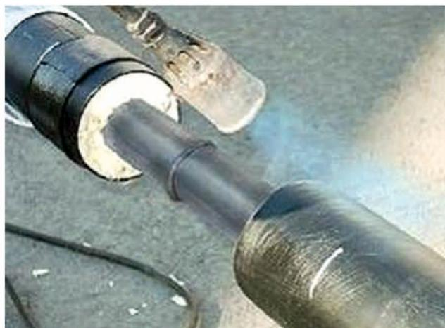
**4.5.5.** Прогреть подготовленные поверхности оболочек с обеих сторон от стыка мягким пламенем пропановой горелки до температуры 120 С. На теплую поверхность оболочек по периметру наклеить адгезивную ленту, армирующим слоем наружу, нахлест на риски 5- 10мм, нахлест адгезива в месте соединения 10- 30мм.
