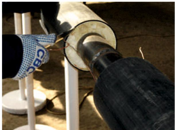
С помощью ножа или стамески удалить с торцов труб на стыке наружный слой пенополиуретановой изоляции на глубину 10 мм, а если изоляционный слой пены намокший, то необходимо убрать на всю глубину мокрую пену. При помощи крепежной ленты прикрепить к металлической трубе держатели проводов.
