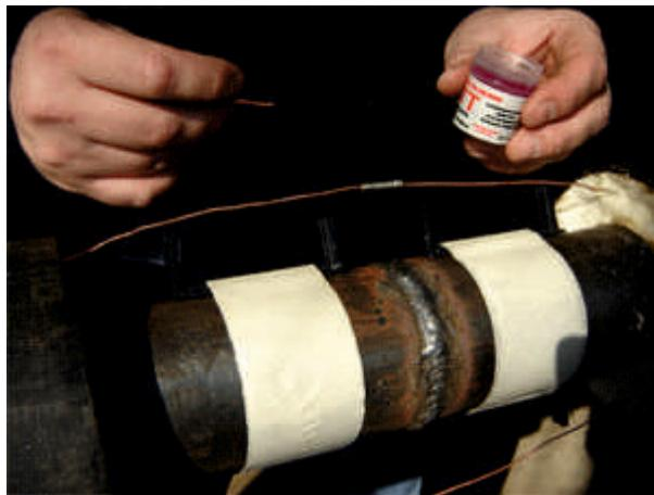
Полученное соединение обработать с помощью неактивного флюса - нанести неактивный флюс на оба конца обжимной втулки.
