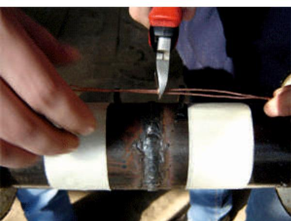
Натянуть провода для соединения «встык» и отрезать лишние части, бокорезами, таким образом, чтобы не было слабины при соединении.
