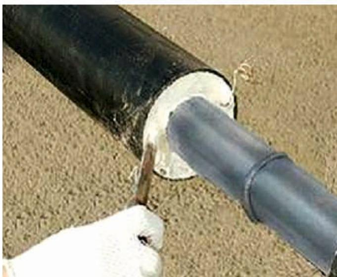
**4.5.2.** На торцах труб удалить слой теплоизоляции на глубину 15-20мм.
