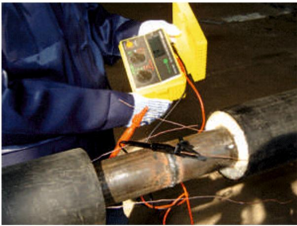
Произвести измерение сопротивления проводов (Rпр.) на первом стыке (начиная от торца трубы) с помощью контрольно-монтажного тестера.
