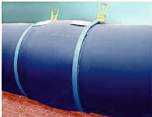
**4.5.12.** Для муфт диаметром 400мм и более после усадки края муфты стягиваются бандажными ремнями шириной не менее 50мм, при этом температура муфты должна быть не менее 110 Со. Ремни снимаются после остывания муфты и П/Э оболочки до +40 градусов.
