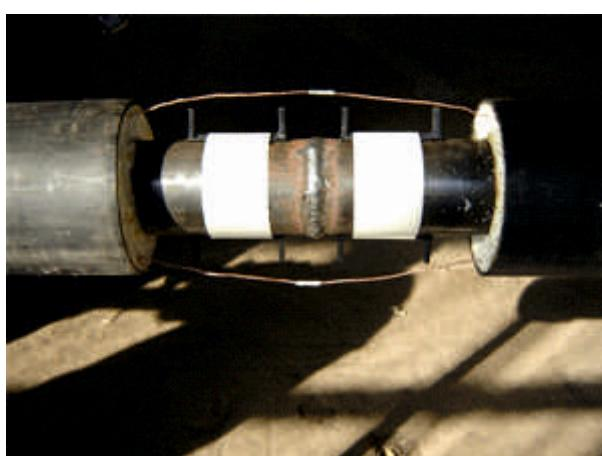
Произвести соединение транзитных сигнальных проводников на стыке также как и основных сигнальных проводов.
