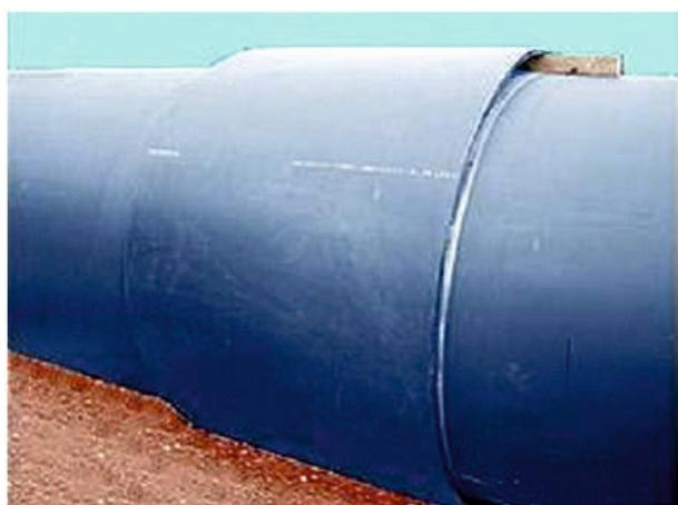
**4.5.8.** Муфты диаметром более 400мм отцентровать при помощи клиньев добиваясь равного расстояния между ПЭ оболочкой и муфтой по верхнему и нижнему срезу.
