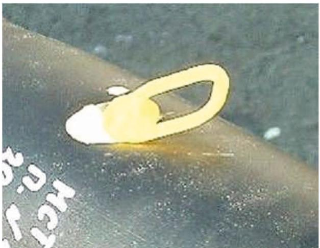
Закрыть отверстия дренажными пробками. В процессе вспенивания незначительное количество пены вытечет через дренажные отверстия пробок, это будет свидетельствовать о полном заполнении объема стыка.
